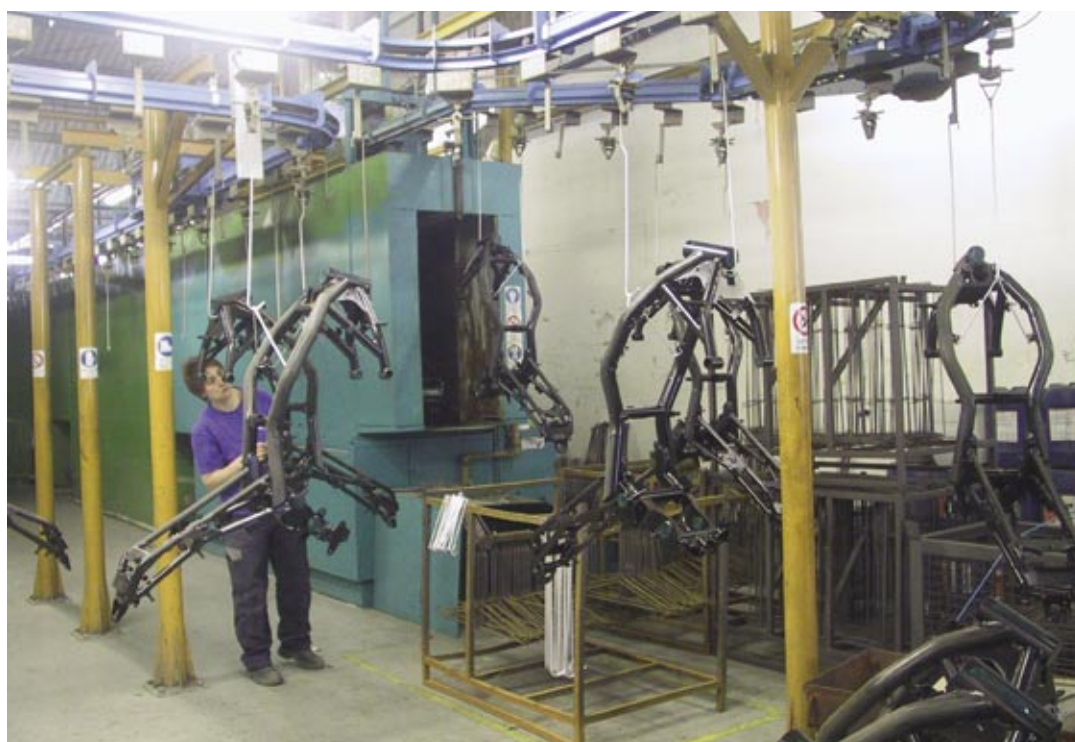
Fig. 7 - Il carico manuale dei pezzi sull'impianto di verniciatura prima dell'ingresso nel tunnel di sgrassaggio di eventuali untuosità e contaminazioni.
